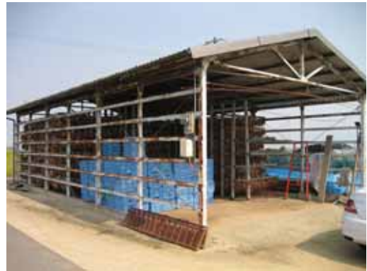
写真10 母球貯蔵施設
