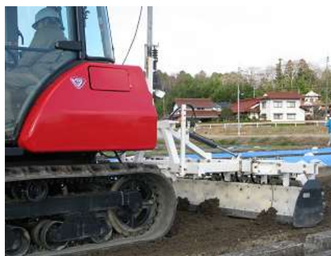
写真2 運土板（幅 3m）での運土作業状況 スプリングタインで砕土、膨軟 スパイルローラで砕土、鎮圧
